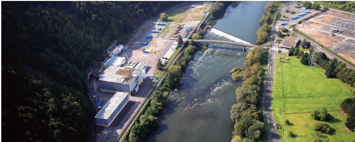
Vue aérienne de l'accès de Chooz A et la colline protégeant le réacteur. Source : http://energie.edf.com/
