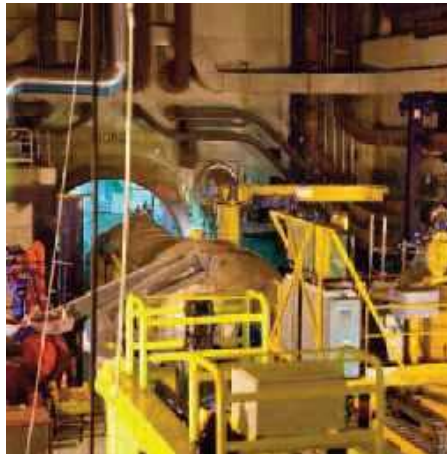
Installations en cours de démantèlement. Source :
