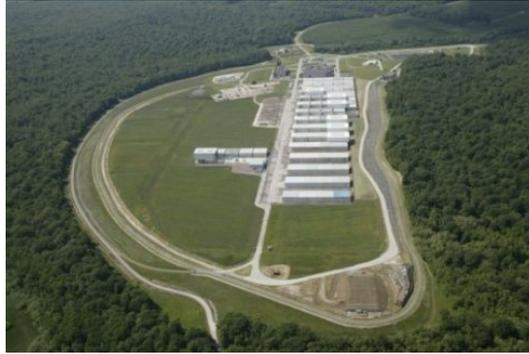
Les colis sont stockés dans des casemates en béton armé. La sûreté est faite par les barrières de béton de l'ouvrage, les matériaux de remplissage entre les colis et par la future couverture en argile (mise en place à la fin de l'exploitation) et la couche d'argile imperméable.
