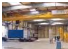
Entrepôt des déchets faiblement irradiants
